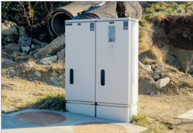
Na območju Občine Cerkvjenjak Telekom trenutno gradi optično omrežje v naseljih ob glavni cesti Lenart – Cerkvjenjak - Sveti Jurij ob Ščavnici, o čemer pričajo lične omarice, ki so zrastle ob cesti.
