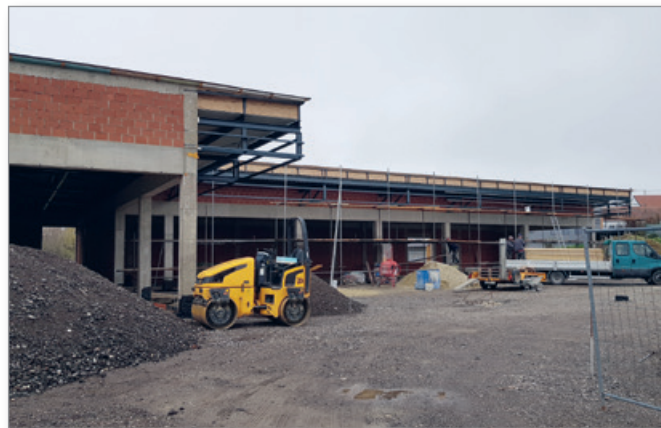
Poslovni objekt Cerkevjak v gradnji
